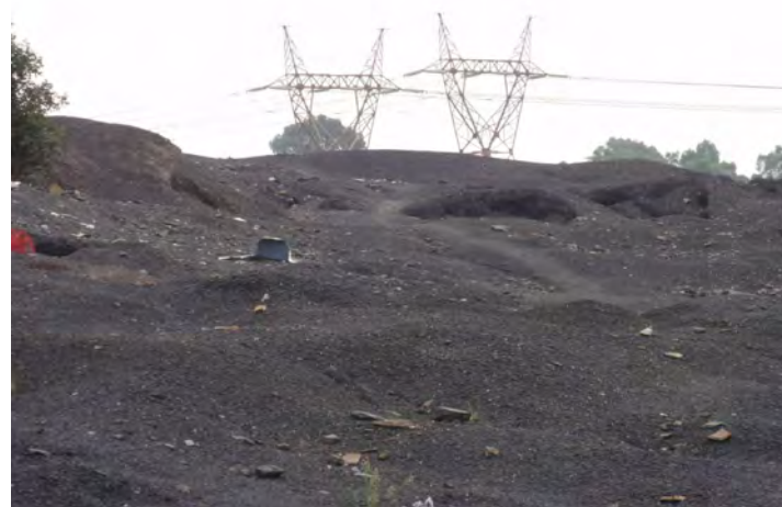
Abraumhalde einer alten Mine in eMalahleni, Witbank
