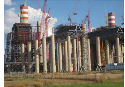
Im Bau: das Kohlekraftwerk Kusile Foto: Saarmann/KOSA
